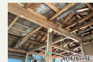
解体後の様子
