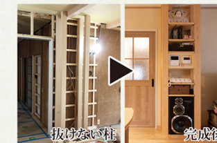
付けない柱 完成後
